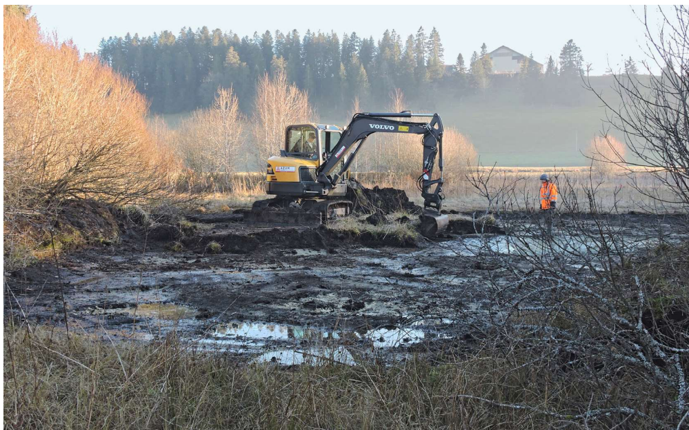
Per riumentificare la torbiera prosciugata, vengono costruite piccole dighe e stagni utilizzando una pala meccanica (foto: Yvan Matthey)
